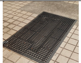
タイル破損箇所 ゴムマットによる対応
