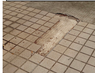
タイル破損箇所 ゴムマットによる対応
